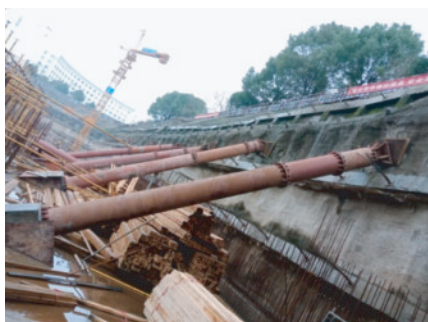
图 1 基坑抢险斜撑(浇筑混凝土基座)
